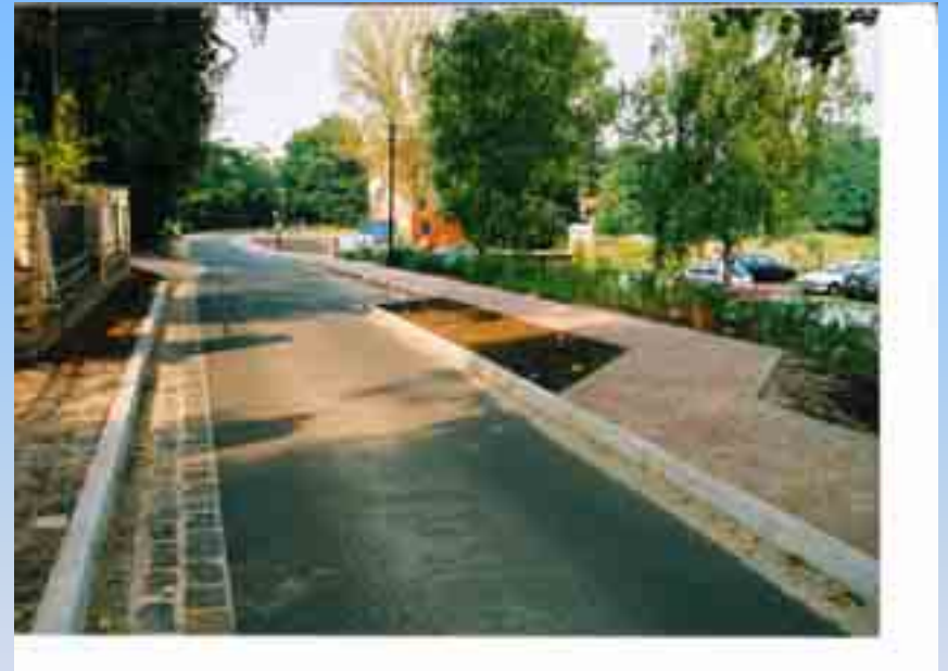
Straßenneubau an der Burgstraße
